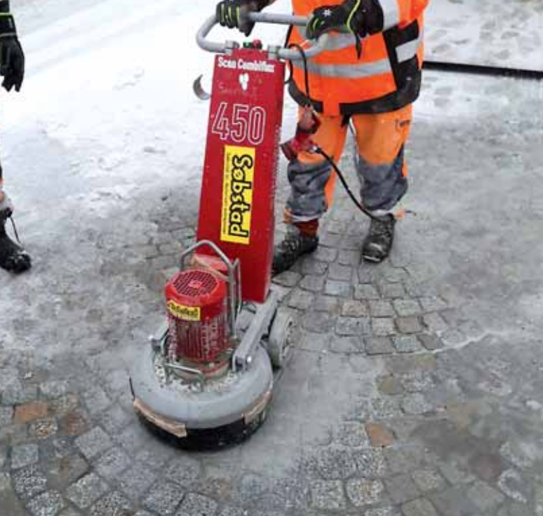
Betonslibemaskinen fjerner de grove ujævnheder. Foto: René Kierstein.
