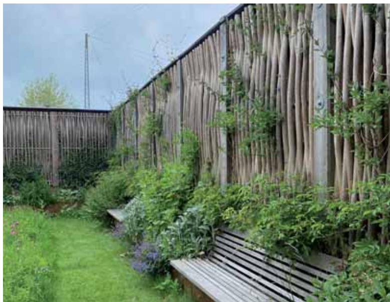
Naturstøjskærm opsat ved Folehaven, Valby. Foto: PileByg.
