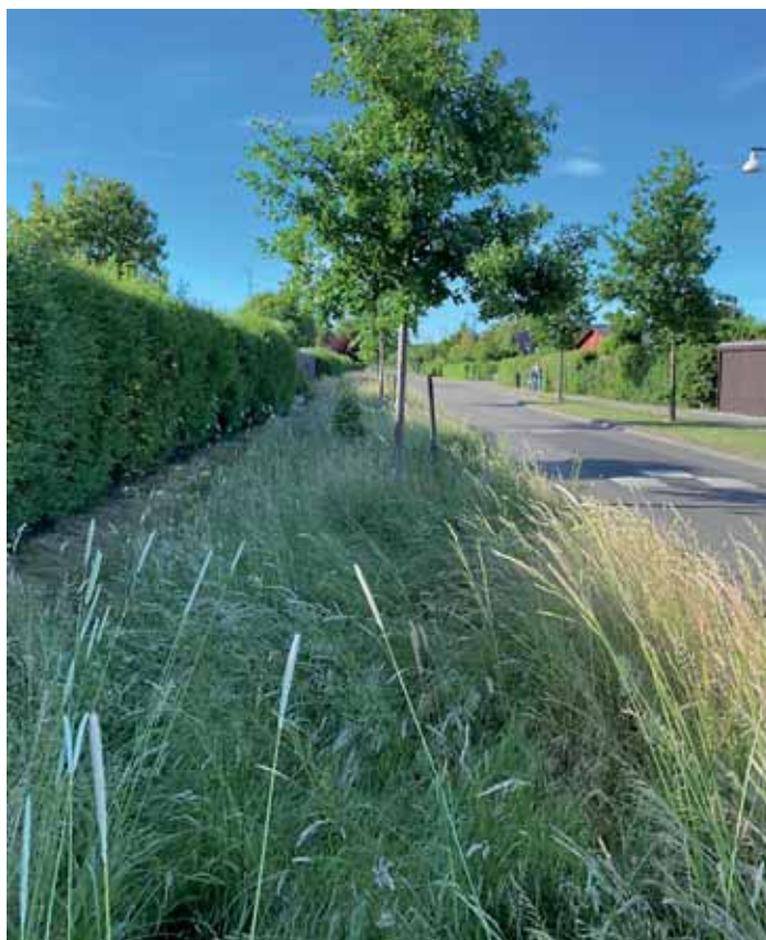
• Trug langs Lørenskogvej i Rødovre. Vegetationen er sået med en frøblanding med både græsser og urter. Rødderne danner en rodmatte der sikrer god kontakt med - og dermed rensning af - det infiltrerende vejvand. Foto: Marina Bergen Jensen.
