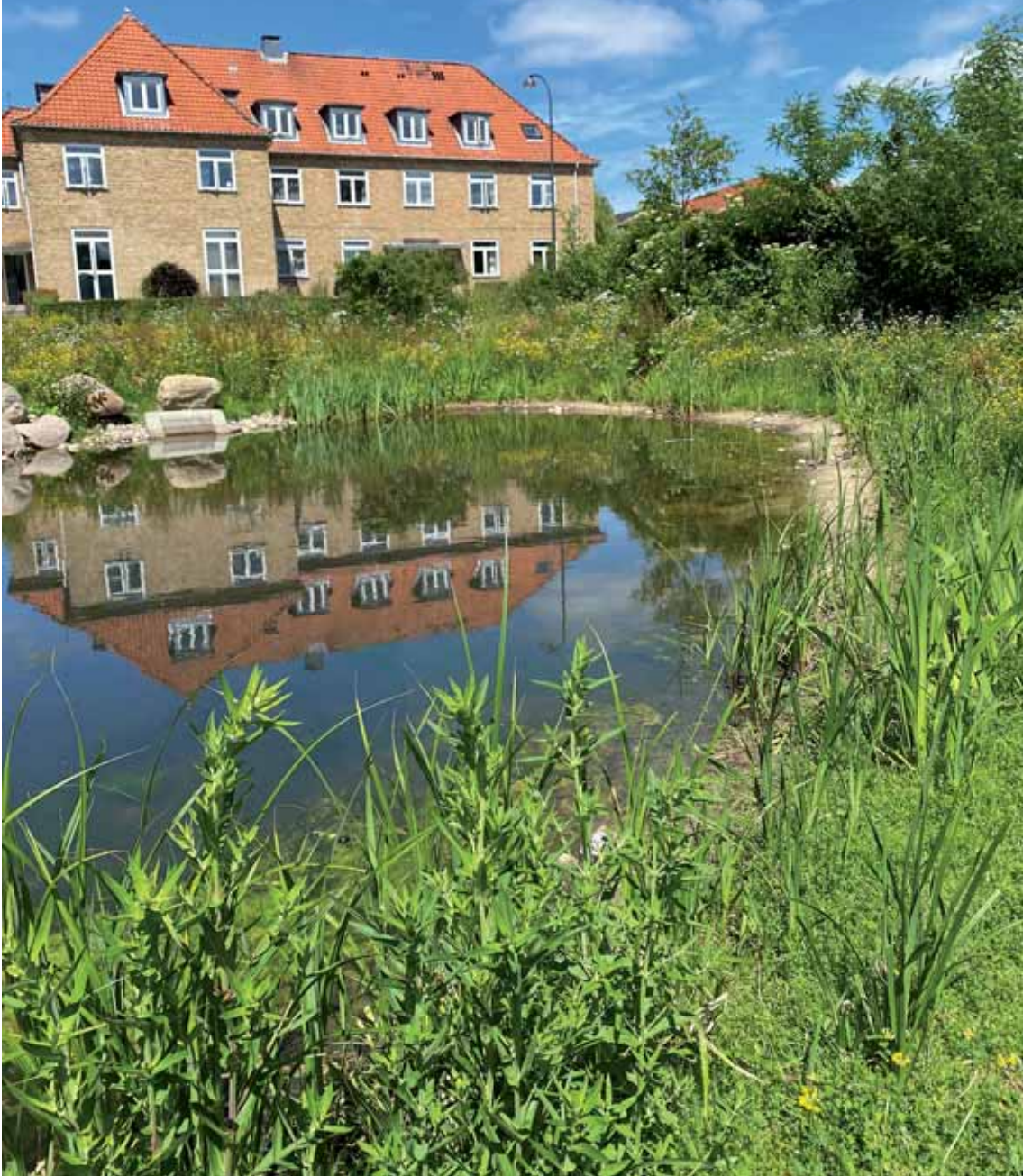
• Vådt bassin med flad kant hvor vegetationen har responderet med en tydelig fugtighedsafhængig brinkvegetation. Bassinet ligger i Mosegårdskvarteret i Gentofte og er fra 2018. Foto: Marina Bergen Jensen.
