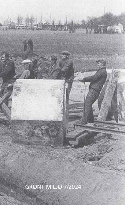
• Hovedkloakken ved Damhusøen anbringes i udgravningen 1935. Det hele foregår med håndkraft. Foto fra bogen.
