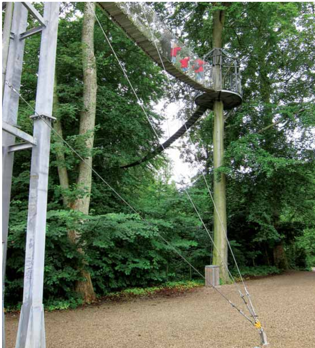
Et stort og dyrt tree top-anlæg der skal holde i mange år. Det er afgørende for banens holdbarhed at der tages hensyn til træerne. Første træ på banen har formodentlig rotskader efter grusudlægningen og barkskader efter ophænget af platformen. Foto: Simon Skov.
