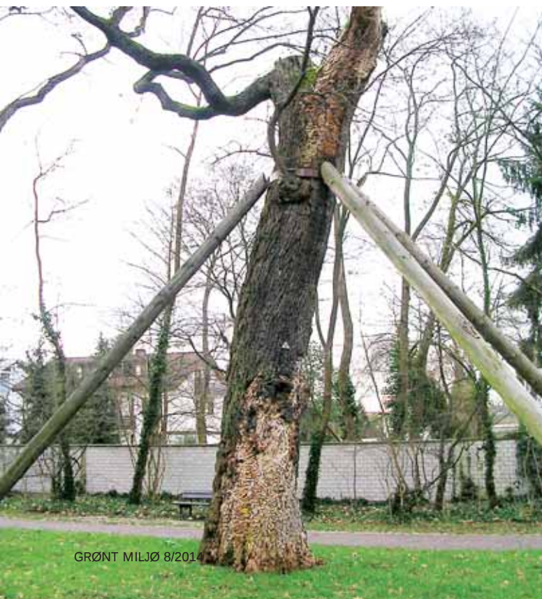
Figur 7. Forankring af træ med stolper. Fysisk stabilisering bør først overvejes når alle andre muligheder er udtømt. Foto: Claus Wurst.
