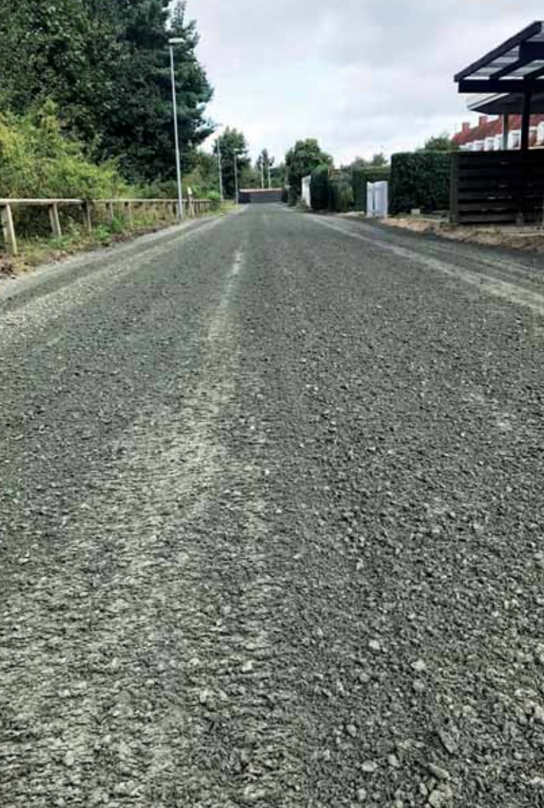
En villavej i Fuglevænget i Køge har fået Hyperit Rabatgrus. Gruset ligger lidt endnu løst fordi det er trafikken der hen ad vejen står for komprimeringen. Foto: NCC.
