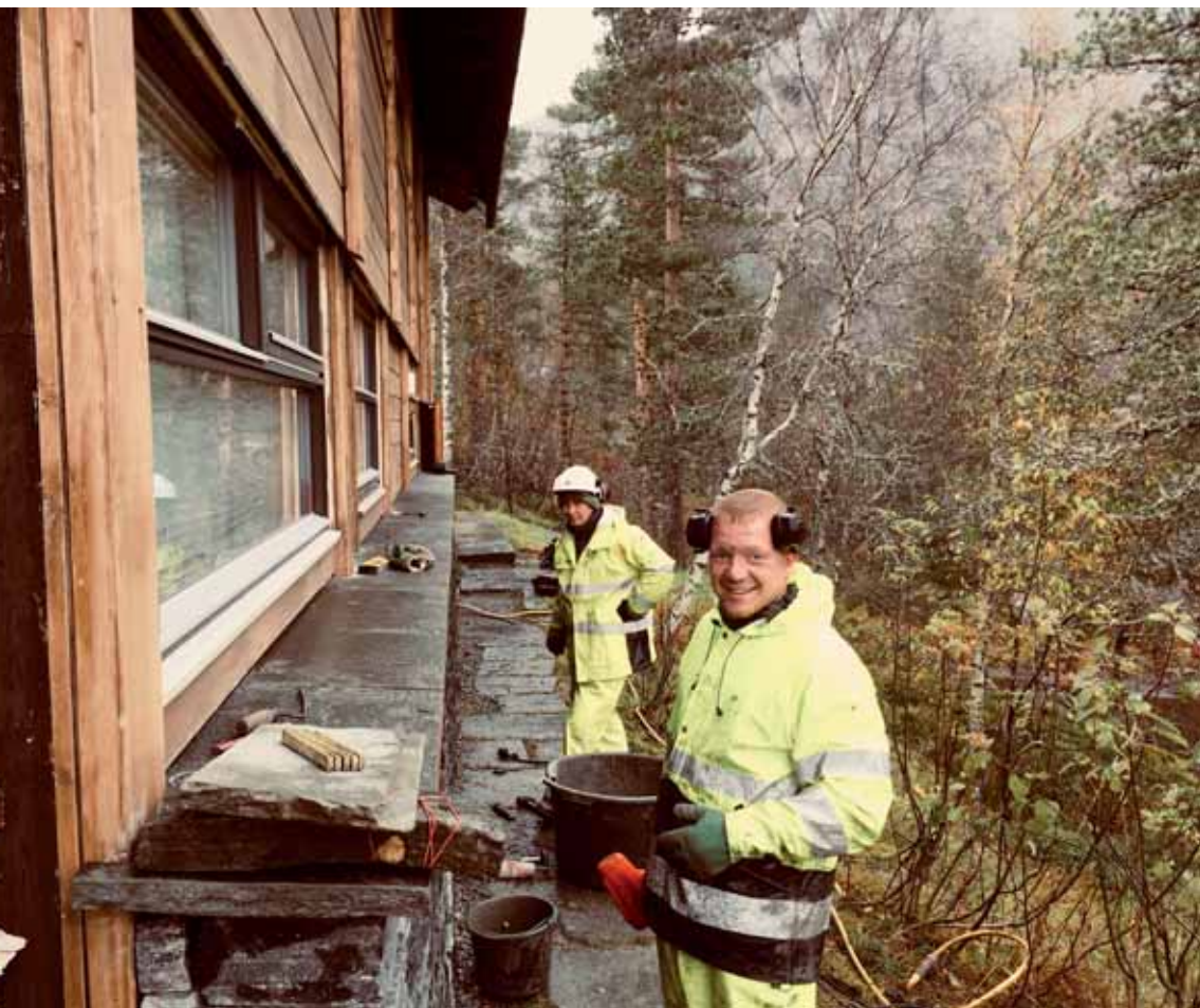
Morten Christophersen (tv) og Morten Jensen er ved at sætte en støttemur op. Foto: Svein Boasson AS.
