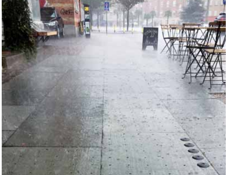
Det regner på klimaflisen 14. august 2018. Vandet løber ned i de mange små huller i overfladen og via kanaler til en faskine. Foto: Tredje Natur.
