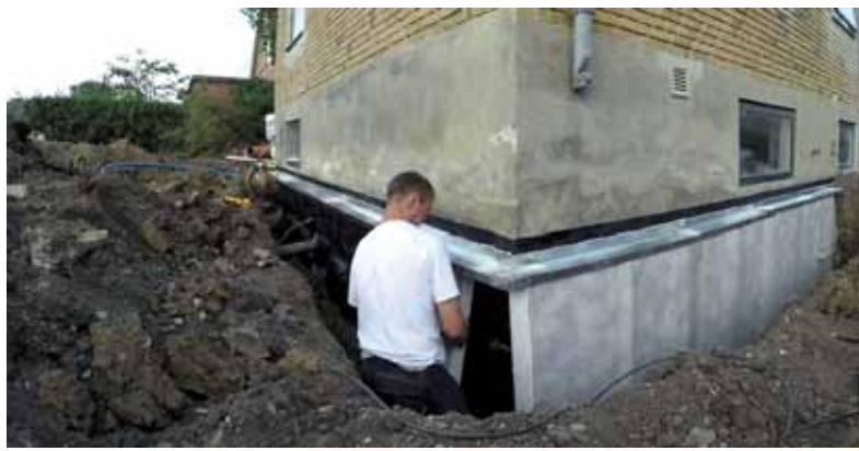
Fundamentet isoleres. Foto: Under Byen Entreprise
