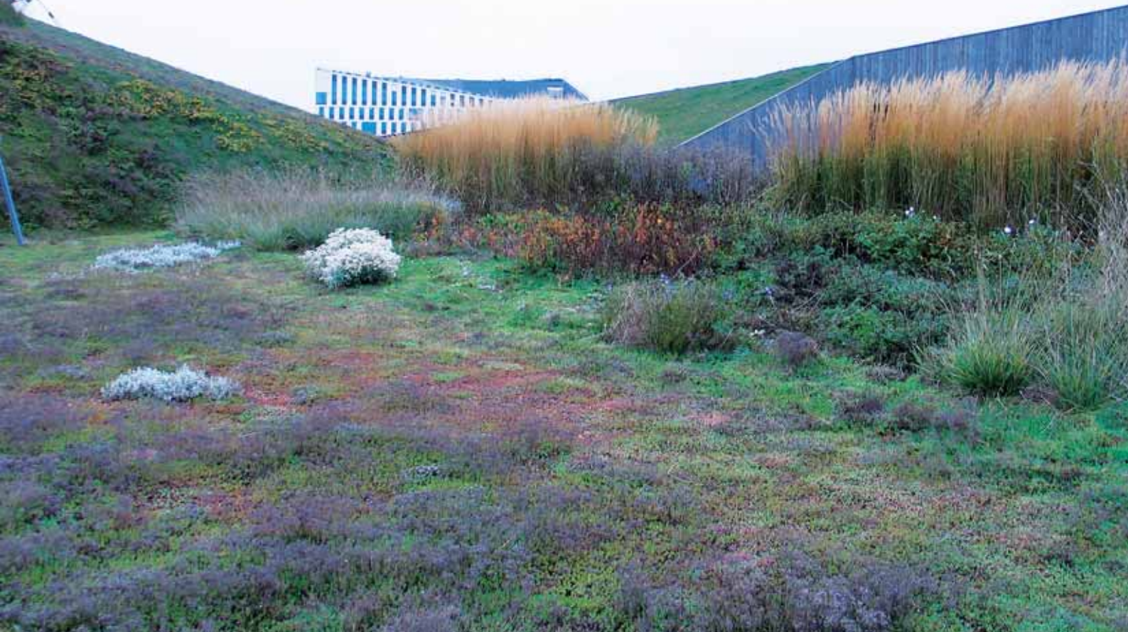
Taghaven på indkøbscentret Emporia i Malmø. Taghaven er kuperet og har store variationer i vækstlag og plantesamfund. Foto: Kim Tang.
