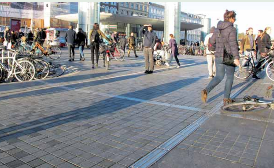
Nørreport Station er inddelt i store felter på 3,6 x 3,6 meter med kantbånd i rustfrit stål.
