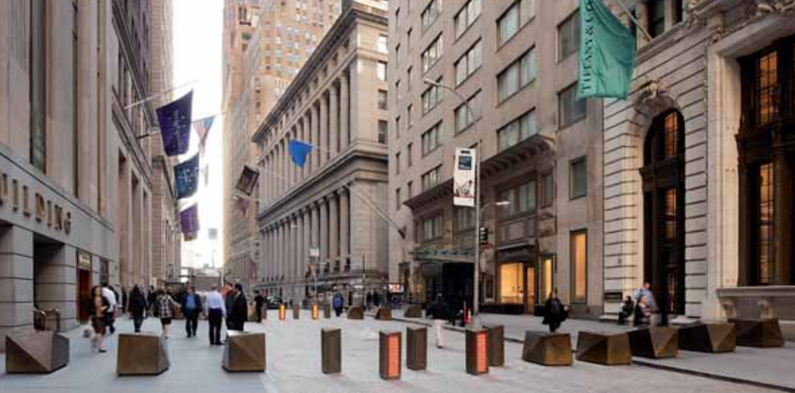
I den dyre ende er der i Wall Street, New York, etableret en løsning med bronzepullerter af mærket 'Nogo' med en vægt på op til over tre tons og en pris på op mod 8.000 $ pr styk. Producenten er Allen Architectural Metals der har valgt bronze fordi det går igen i mange af gadens indgangspartier. Foto: Rogers Partners.
