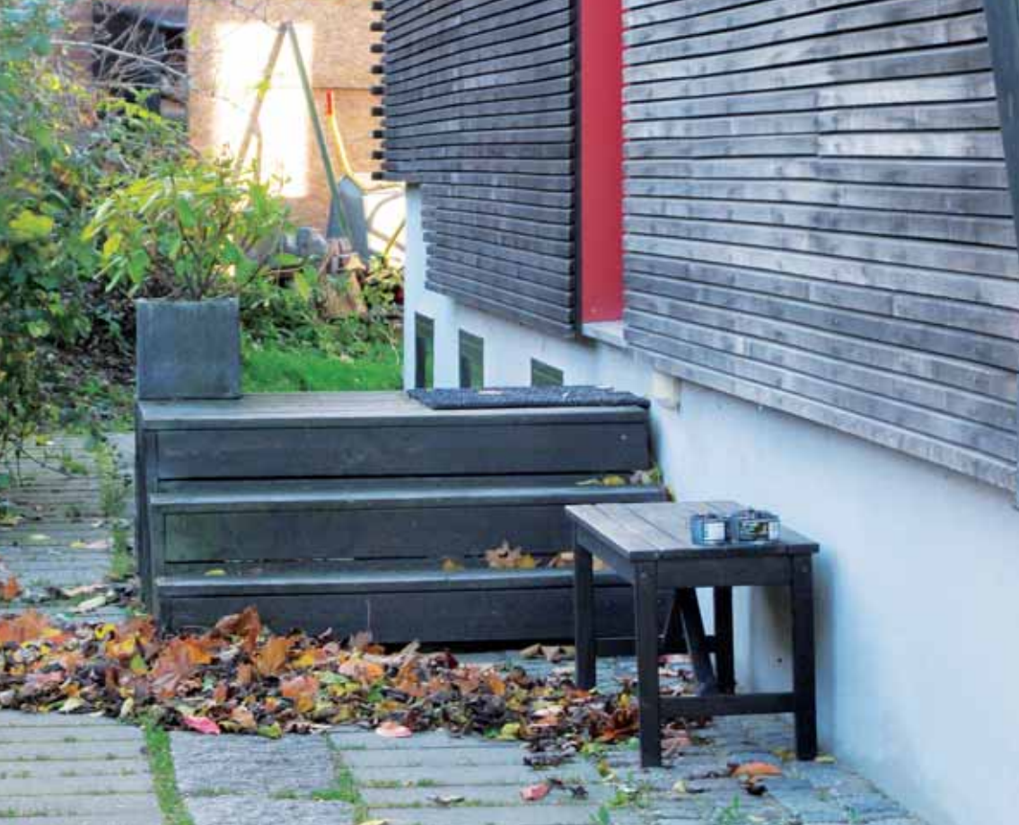
Før 1. juli gik dette ikke an ved nyopførte huse. Nu gør det nu, for der kan etableres niveaufri adgang.
