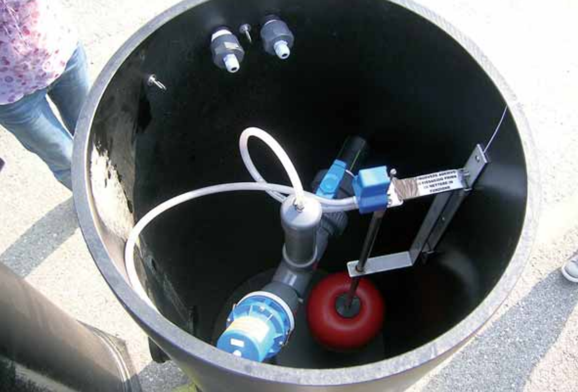
Brønd i et vakuumkloakeringssystem, her fra Progeco i Italien. Progecosrl.com.
