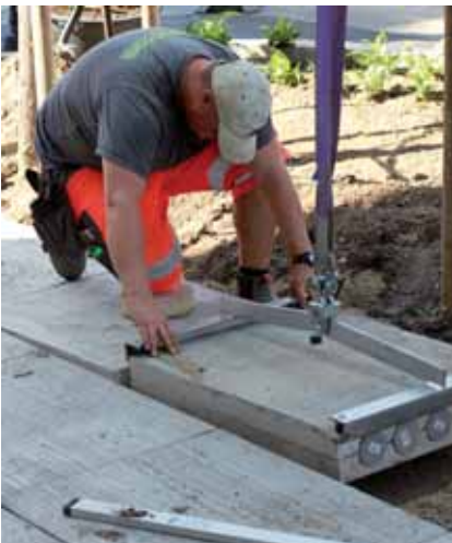
Malmos A/S lægger klimafliser i Heimdalsgade 4/9 2018. Foto: Malmos A/S.
