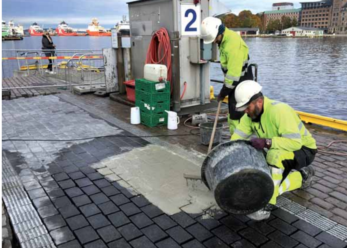
Betonblandingen hældes ud over belægningen og arbejdes ned i fugerne med svaber. Foto: Svein Boasson AS.
