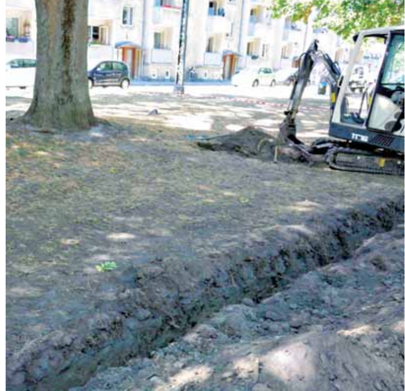
Figur 7. Er der god plads, graves en eller flere grøfter i passende afstand fra træet for at få kendskab til røddernes lejring og størrelsesfordeling.
