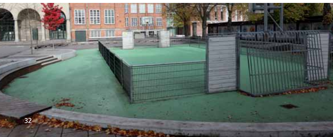
Skolegården bygges i 2018 om med to store 'skåle' med regnvandskassetter nedenunder. Anlægget rummer 700 m 3 i kassetterne og 800 m 3 i skålene. I den ene skål er der boldbane med en grøn gummibelægning.
