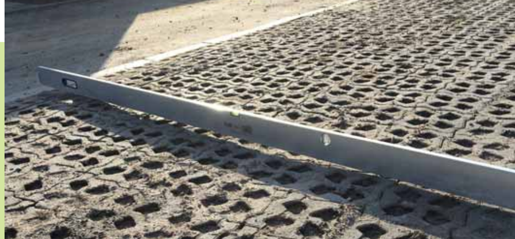
Med en 3 meter retskede måles jævnheden på belægningen af armeringssten. Foto: Kim Tang.
