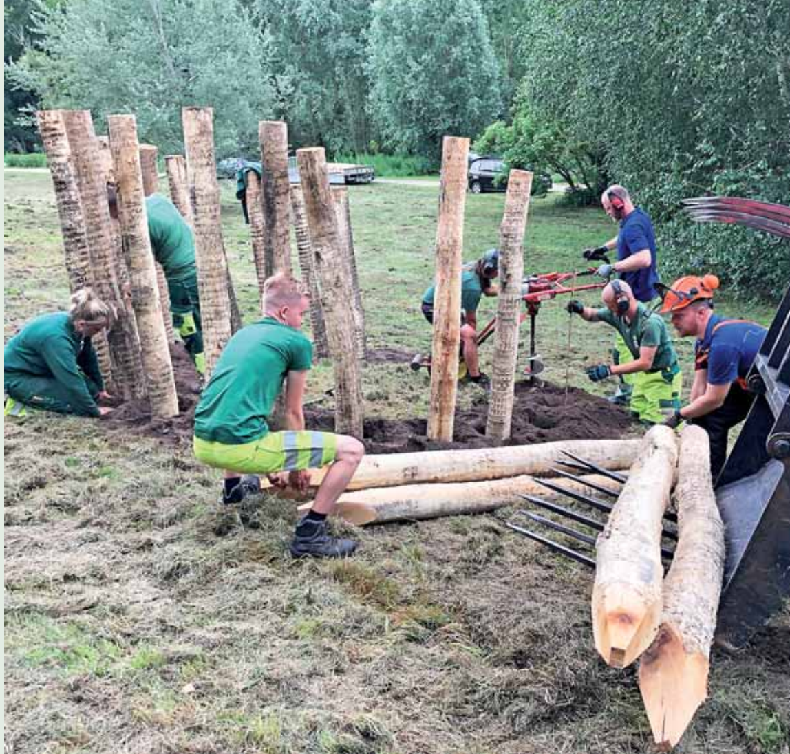
• I gang med elevprojektet, her etablering af et kvashegn med pæle og pælebor. Foto: OKNygaard.
