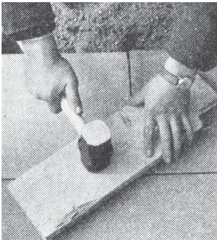
Fliser stødes på plads med brædt og hammer. Gengivet fra bogen.
