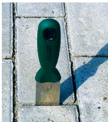
Fugebredden kan kontrolleres 10 mm under belægningsoverfladen ved nedstik med søgerblad o.lign. Foto: Belægningsfraktionen, DBI.
