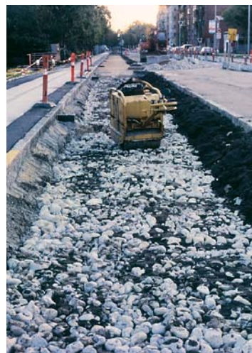
Udlægning af stenlag før mulden vandes ned i rodvenlig befæstelse. Foto: Palle Kristoffersen.
