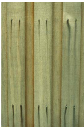
Garvesyren i træet korroderer søm- mene og danner sorte striber ned af plankeværket.
