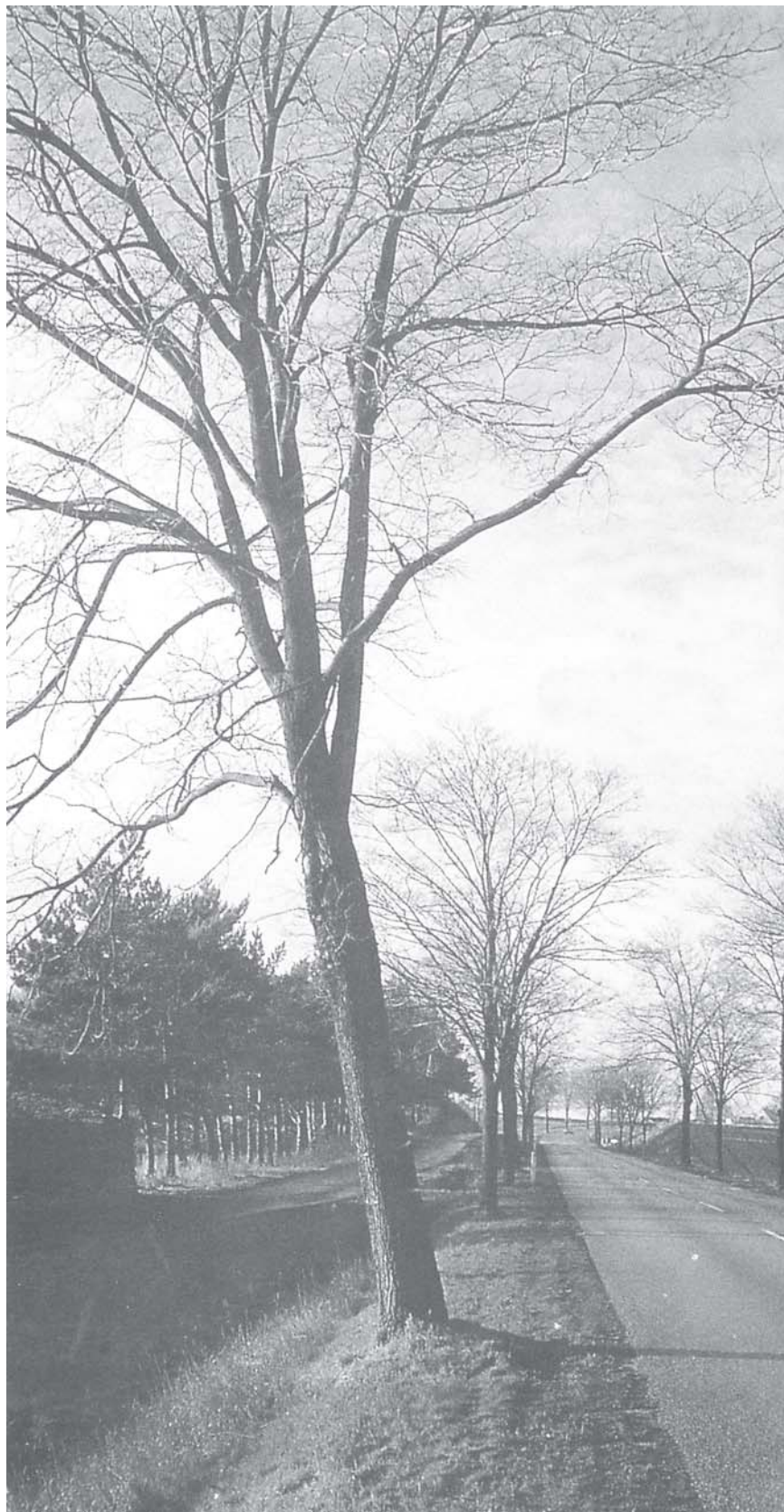
Stabiliseringsrødder er afhugget og belægningen retableret. På denne vejstrækning er flere træer væltet.
