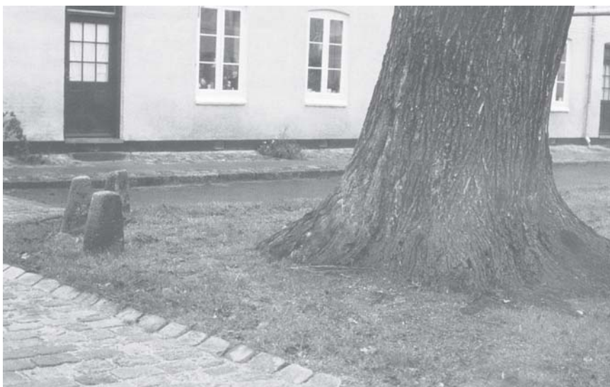
Det ser pænt ud, men i byggefasen blev der kørt rundt om træet i en afstand af en meter. Der er nu døde områder på stammen. Hvor mange rødder er ødelagt? Er træet farligt? Bygherrens rådgivere er underrettet om risikoen.
