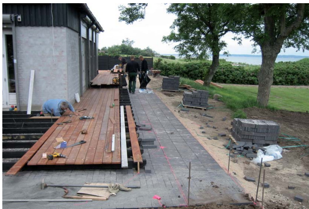
Hos Birkely A/S er arbejdet fordelt 50-50 mellem anlæg og drift. Her ses de i færd med at lægge belægning ved et sommerhus ud til Storebælt.
