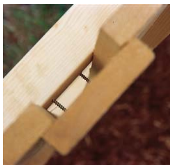
Lodret beklædning set fra oven. Søm/skruer går kun gennem ét brædt. Sømmes to brædder sammen med samme søm, vil begge brædder flække. (Foto: Torben Dam)
