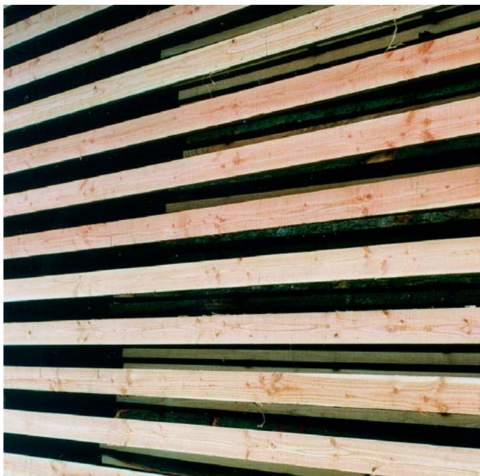
Douglasbrædder som åben beklædning af tørrehal på Hvalsø Savværk. Læg mærke til de store knaster koncentreret omkring grenkransene. (Foto: Dorte Klarskov Petersen)
