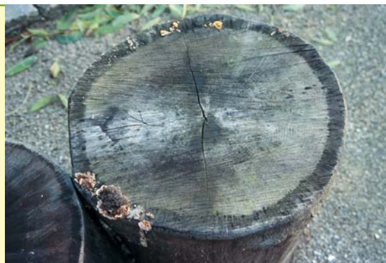
Egetræsskammel med en opfugtet splint og en mere tør kerne med svindrevner. (Foto: Torben Dam)
