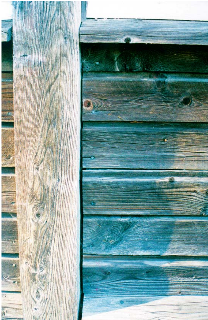
De tykvæggede høstvedceller svinder og bulner mere end vårvedscellerne, hvorfor smårevner i træets overflade meget ofte opstår langs årringsgrænser. (Foto: Christian Lyck)
