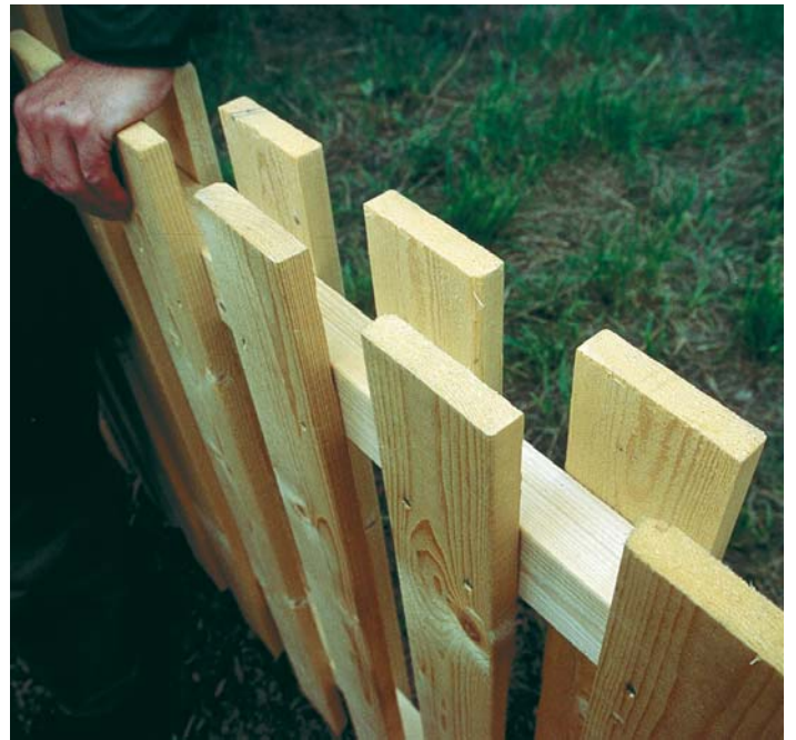
Stakit med samme slags brædder lige efter opsætning. Der er ingen svindrevner og farven er lys gullig. (Foto: Torben Dam)
