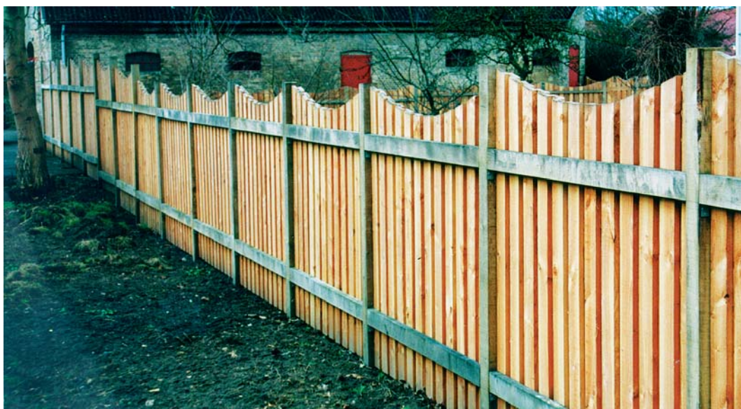
Nyt plankeværk på Hvalsø Savværk med stolper af eg og beklædning af douglasgran. (Foto: Dorte Klarskov Petersen)
