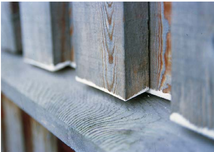
En af træets mekanismer til at suge vand fra rødderne op til bladene er kapilære kræfter i de smalle fiberceller. Disse kræfter fungerer stadig efter træet er opskåret hvorfor endetræ groft sagt op-suger 100 gange så meget vand som siderne. Beskyt derfor endetræ bedst muligt. Konstruktivt og eventuelt som her med endeforsegling. (Foto: Torben Dam)
