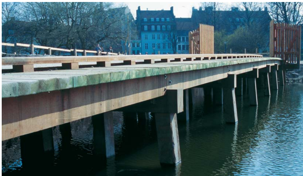
Kastelsbroen hvor forskelligt tømmer indgår. Stolper og bærende bjælker er tropisk træ. Brodækket er trykimprægneret træ. Arternes forskellige farver kan anes på billedet der er taget lige efter broen er bygget. Det trykimprægnerede træ kunne erstattes af rødkernede træarter. (Foto: Torben Dam)
