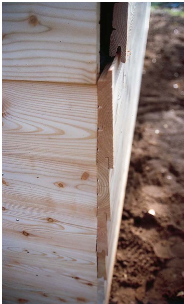
Profilerede brædder er savet eller fræset til en særlig form for montering f.eks. klinkbeklædning. Profileringen skal være lavet så marven altid kommer udad. Det er - som man også kan se her - ikke altid tilfældet i praksis. (Foto: Torben Dam)
