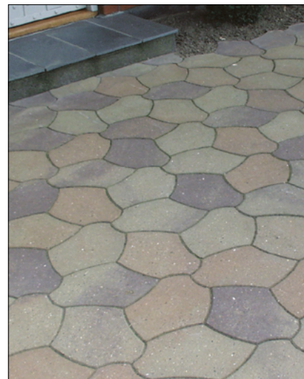
Til venstre ses almindelige kalkudfældninger på farvede sten. Billedet til højre viser samme belægning 2 år senere. Det ses, at kalkudfældningerne er væk, hvilket skyldes almindeligt slid samt vind og vejr generelt.
