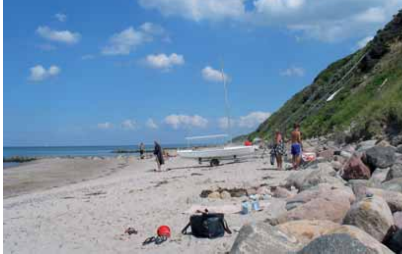
• Erosionsfaren er stor mange steder i landet, bl.a. her hvor man prøver med både høfder og skråningsanlæg af kampesten.
