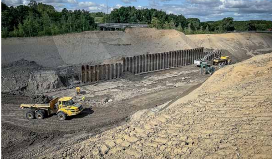
• Ved Koelbjergvej bliver der afgraved cirka 380.000 m 3 jord. Meget af den afgravede jord er ler som er velegnet til indbygning i baneanlægget. Foto: Vejdirektoratet.
