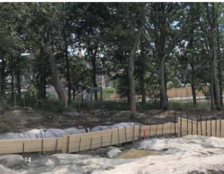
• Gravekasse og rodspuns kan reducere udgravningen. Foto: Örjan Stål.
