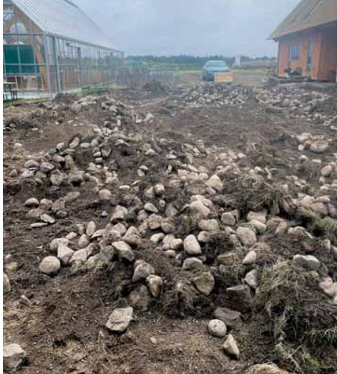
• Det er ikke til at vide hvad der gemmer sig i jorden. Det tager Melbymetoden højde for da endelige tegninger mv. først udfærdiges når der er fuldt overblik over situationen på stedet. Her ses Lerbjerggards gårdsplads undervejs i fase 1 - rydning. Foto: Anna Maya Handberg.
