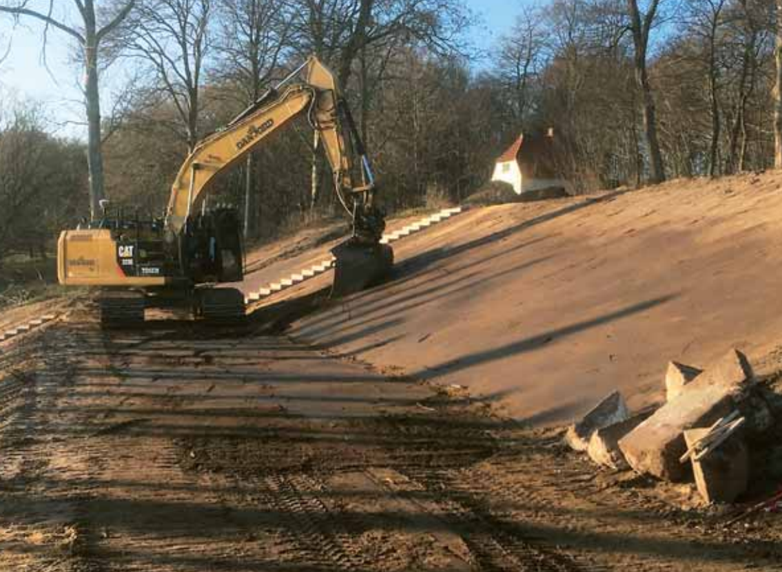
• I barokhaven skulle det terrasserede terræn genskabes til at stå helt skarpt, og det krævede - som så meget andet i projektet - stor præcision i anlægsarbejdet. Foto: Danjord.
