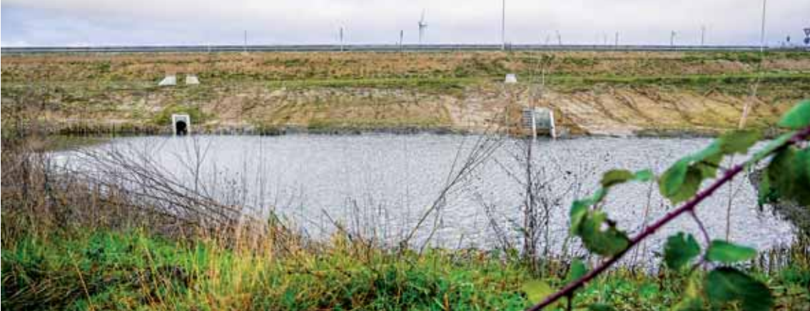
• Regnvandsbassin ved Fynske Motorvej. Her sker der kun en vis rensning af vejvandet. Foto: Vejdirektoratet.
