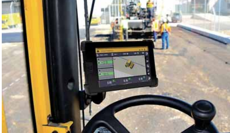
• Trimble Roadworks vises direkte i maskinen og styrer asfaldtumlægningen efter 3D-model. Foto: Sitech Denmark A/S.
